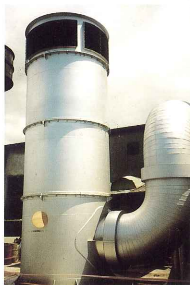
大型ターボコンプレッサー 吸気サイレンサー
