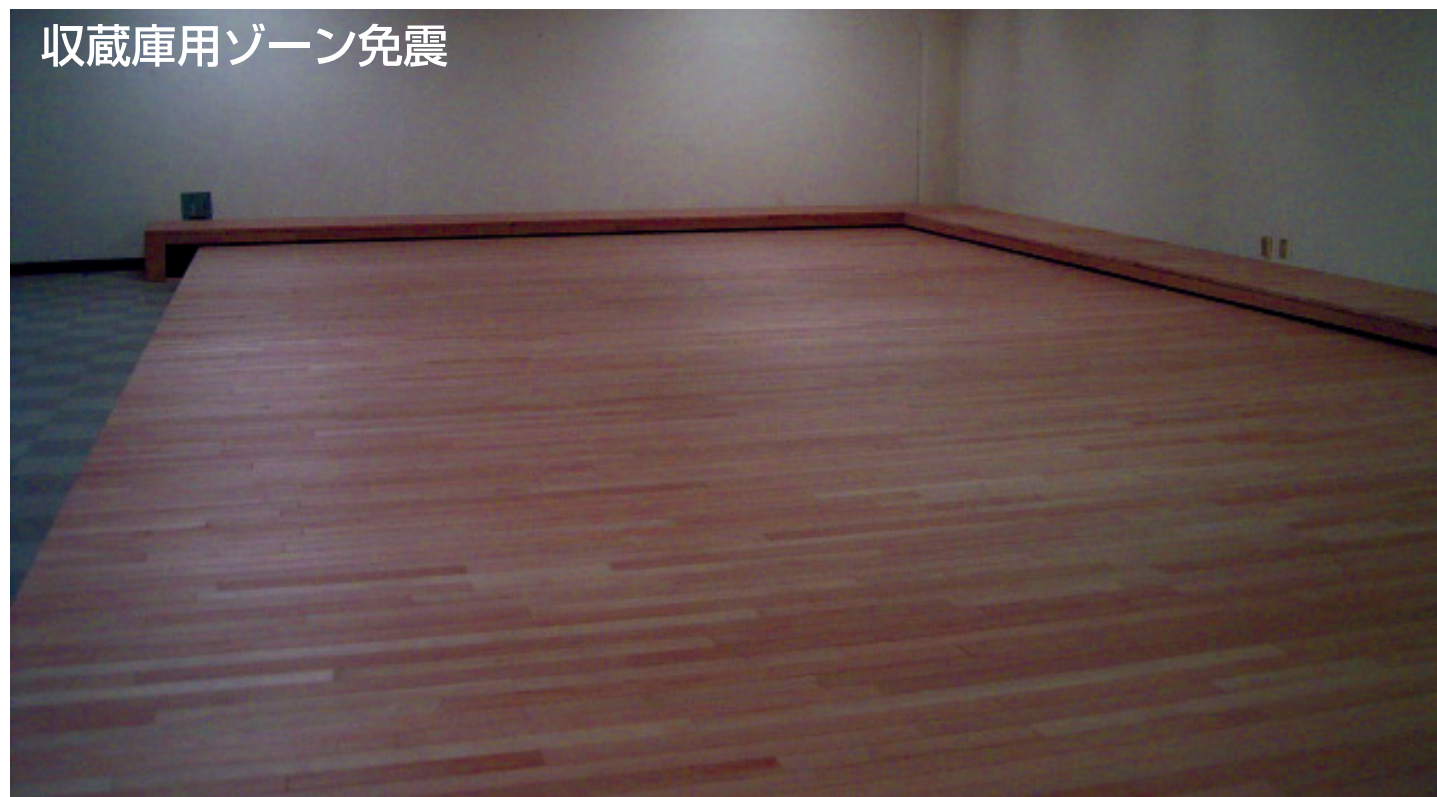
フローリング完了
